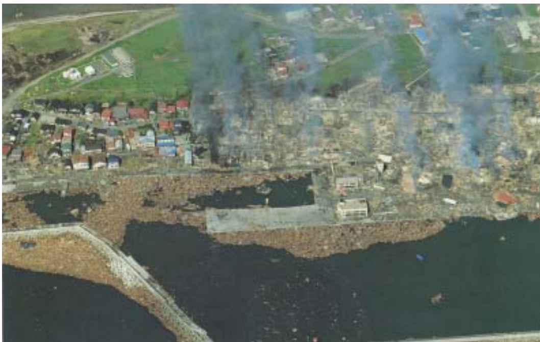
北海道南西沖地震津波による被害（平成7年(1995) / 北海道奥尻町青苗地区）
