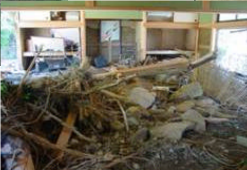
流木と土砂が覆う一時避難場所
