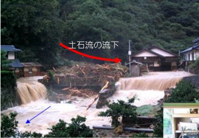
土石流の直撃を受けた落合自治会館
