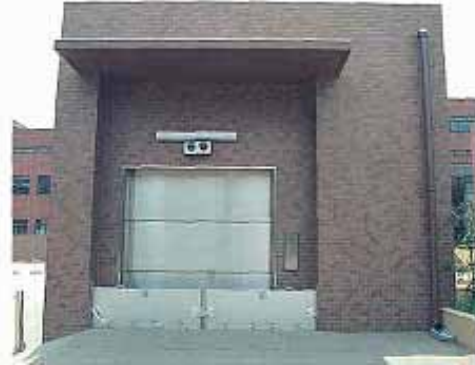
止水板の設置(鶴見川流域)
