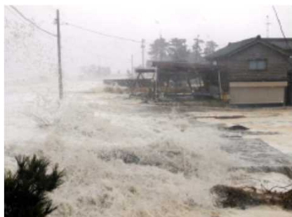
下新川海岸 高波による越波状況 (入善町芦崎地区)
