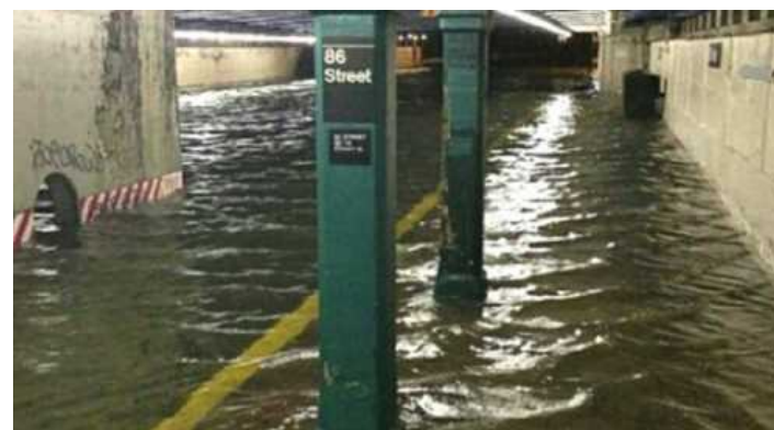
地下鉄86ストリート駅の浸水状況 ©MTA
