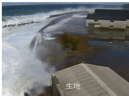
下新川海岸 海岸堤防の越波状況 (黒部市生地地区)
