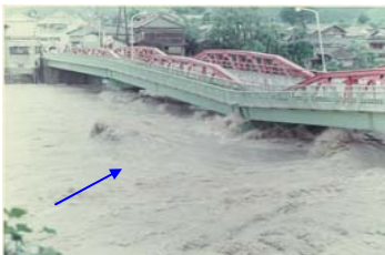
昭和47年7月洪水での香我美橋の橋脚の流失（香美市神母ノ木地先）
