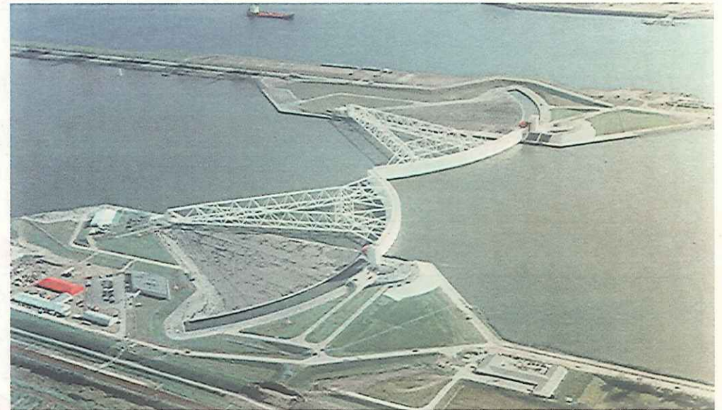
マエスラント高潮堰 (Maeslant Storm Surge Barrier)
