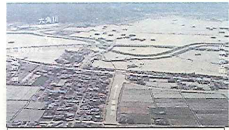
H2.7洪水 R34の冠水状況
