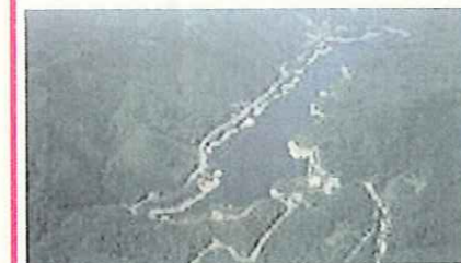
菅沢ダム(昭和43年9月竣工) 目的: 洪水調節、かんがい、工水、発電
