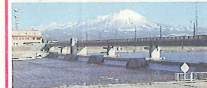
日野川堰(平成5年竣工) 目的: 農業用水の安定供給
