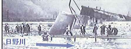
昭和9年9月 洪水による鉄道橋の落橋 (日野町: 第三日野川根雨鉄橋)
