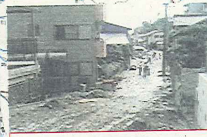
岡崎市伊賀町浸水被害
