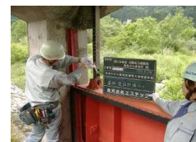
樋管ゲートの点検
