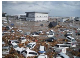
津波による空港内の冠水
