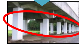
鉄道施設の耐震対策
