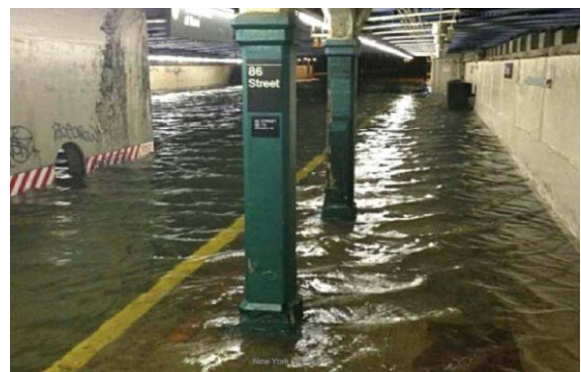
浸水した86ストリート駅 (現地調査時MTA提供資料)
