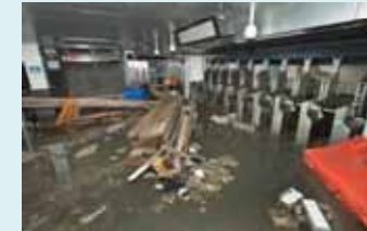
地下鉄駅の浸水状況 ©MTA
