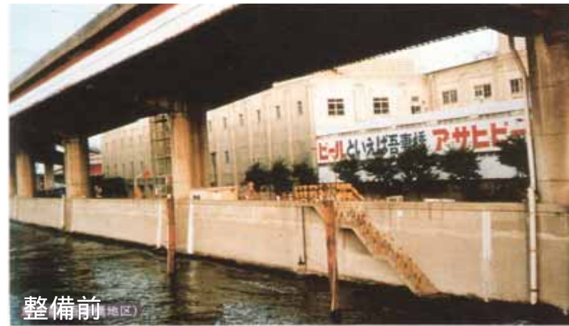
隅田川 吾妻橋地区の例 (東京都)
