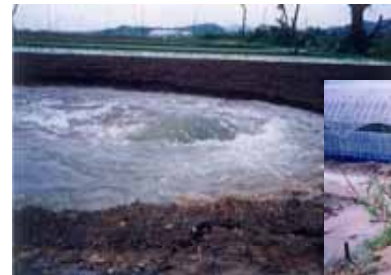
伊良湖サイホン漏水状況
