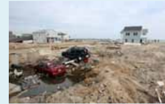
沿岸部の家屋損壊状況 ©USACE
