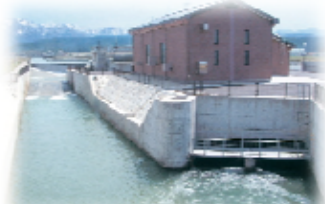
七ヶ用水発電所(手取川水系手取川)
