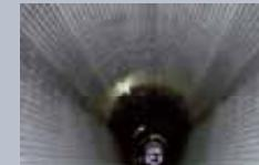
柔軟に曲がる管を使用することにより、耐震化
