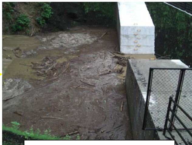
土石流発生直後 (H26.8.20)
