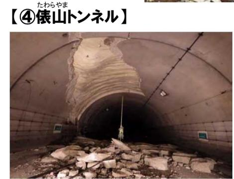
▲覆工コンクリートの崩落
