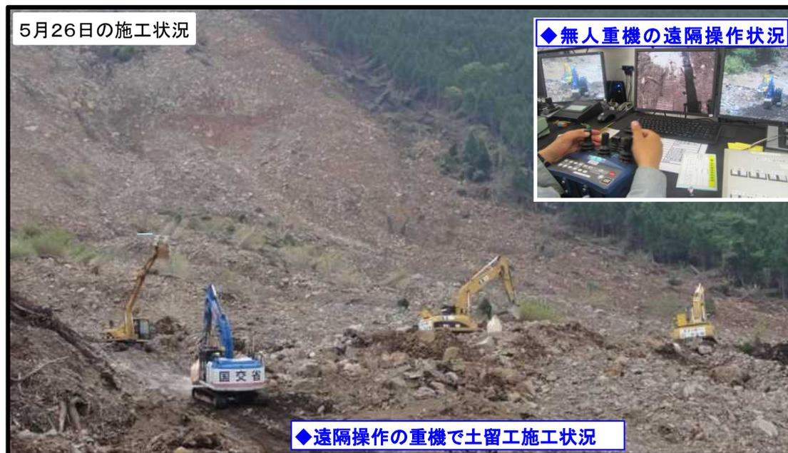
◆遠隔操作の重機で土留工施工状況
