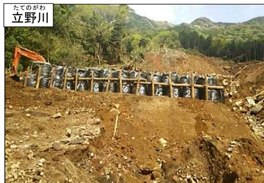
大型土のう設置状況 (4月22日完了)
