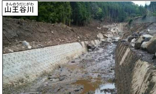
流路閉塞土砂掘削状況 (4月25日完了)
