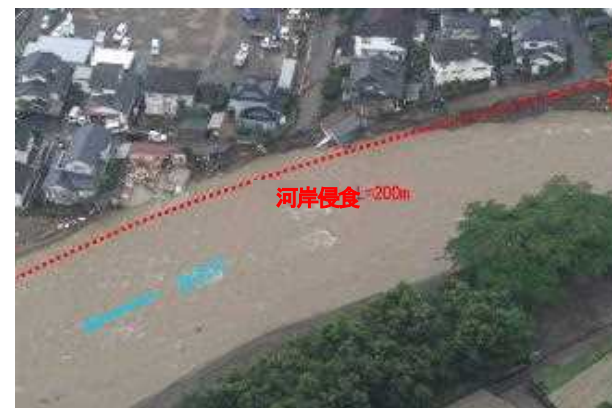
河岸侵食に伴う家屋倒壊
