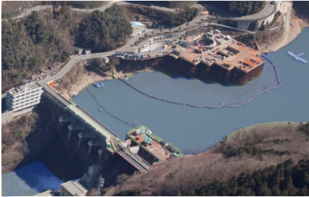
ダムを運用しながら、施設を改良
