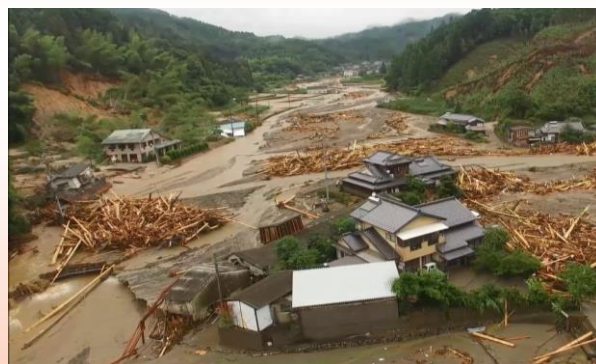
大量の土砂で埋没した赤谷川
