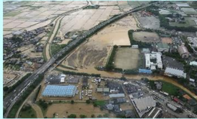
桂川における洪水被害 福岡県朝倉市
