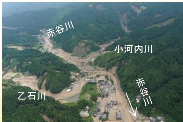
筑後川水系赤谷川における土砂・流木による埋塞状況
