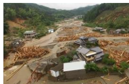
住宅地に氾濫する土砂・流木
