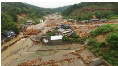
赤谷川における土砂・流木被害
