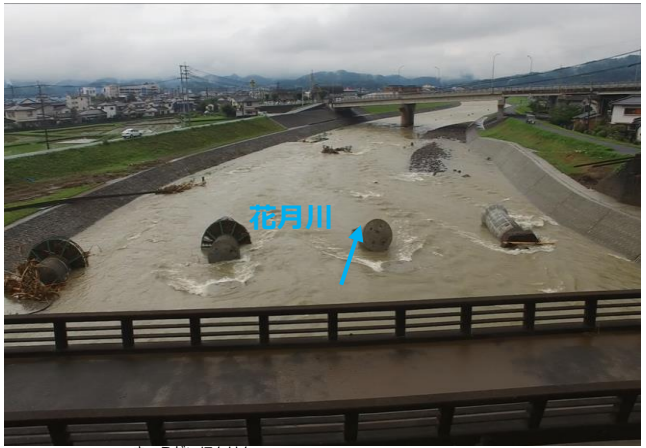
きゅうたいほんせん JR久大本線花月川橋梁の流出状況 (大分県日田市)
