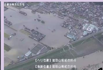
貴志川におけるポンプ排水の状況 和歌山県紀の川市
