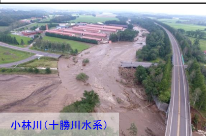
国道38号 小林橋の被害状況
