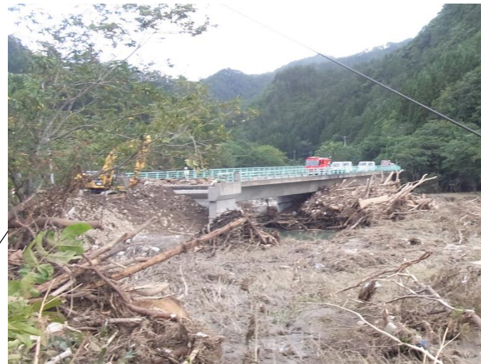
橋梁被害状況(乙茂地区)
