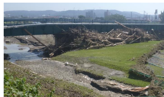
流木による断面阻害状況(久慈川)
