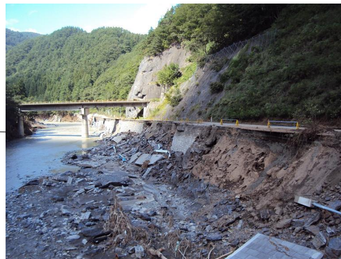
国道455号の道路被害状況(二升石地区)
