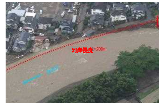
河岸侵食に伴う家屋倒壊等
