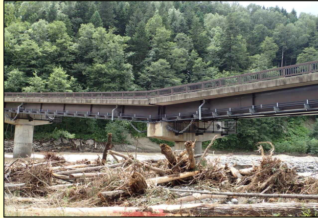
〔高原大橋(国道273号)〕
