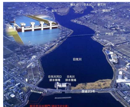
日光川水閘門改築事業
