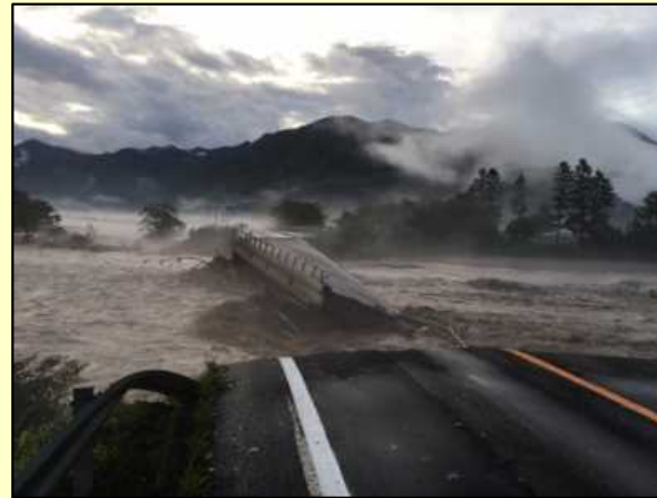
〔千呂露橋(国道274号)〕
