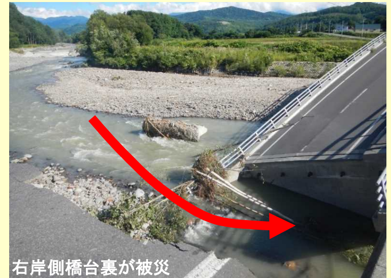
辺別川九線橋の被災(H28.8出水)
