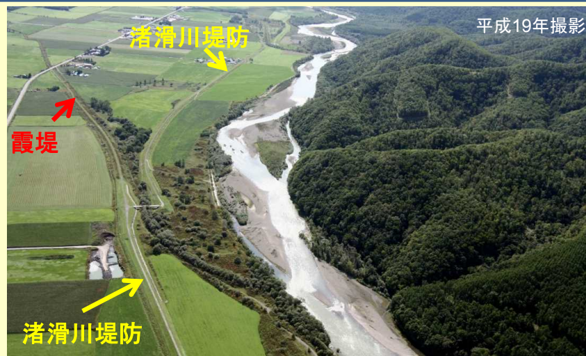
霞堤施工事例(渚滑川)
