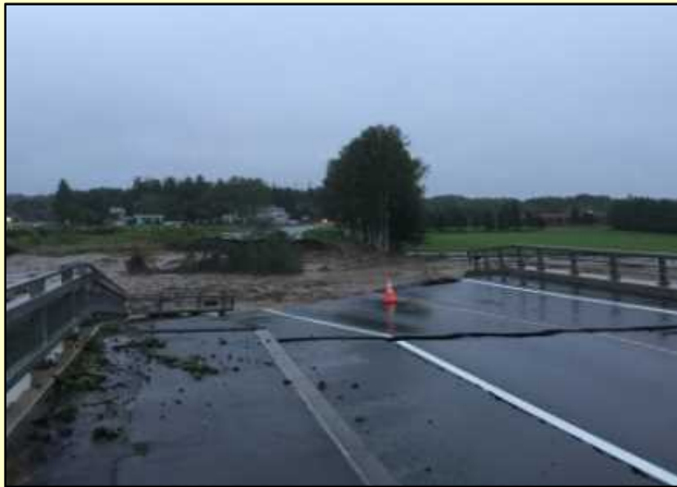
〔小林橋(国道38号)〕
