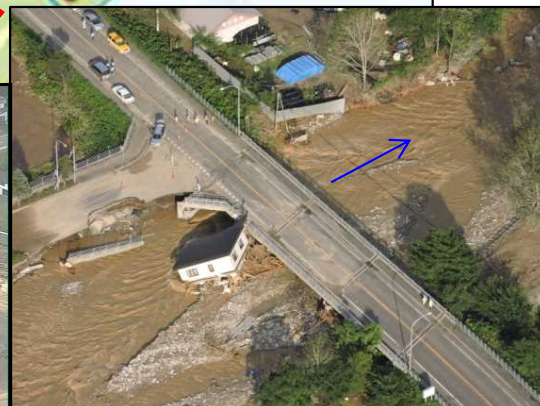
とちかがわ 十勝川水系ペケレベツ川(被害状況)H28.9.1撮影
