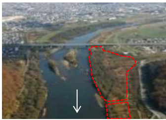
・河道掘削や樹木伐採
