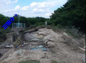
【表法崩れ】L=70m 小田川右岸4k400付近
