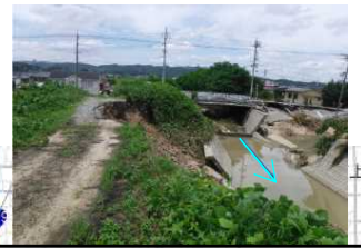
【堤防の決壊】L=20m 末政川左岸0k400付近(県)
