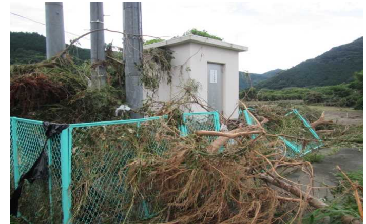
放流警報設備の浸水後の状況
