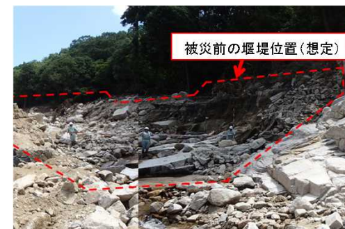
石積砂防堰堤の被災例 (広島県安芸郡坂町 天地川)
