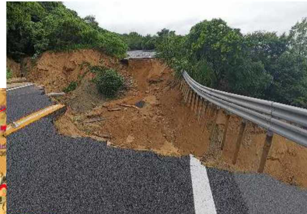
広島呉道路 坂南IC～天応西IC(広島県安芸郡坂町)
