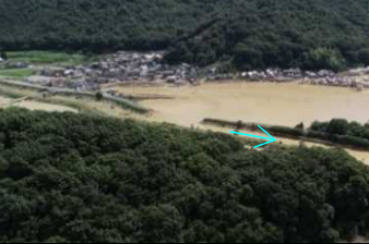
【堤防の決壊】L=100m 真谷川左岸0k300付近(県)
