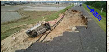
【裏法崩れ】L=80m 小田川左岸4k200付近
