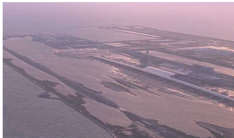
平成30年台風第21号による関西国際空港における高潮被害
