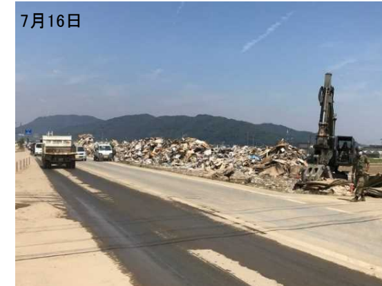
国道486号線付近（岡山県倉敷市）
