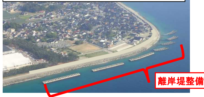
離岸堤の整備による高潮対策事例
