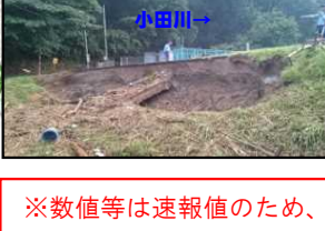
【裏法崩れ】L=16m 小田川右岸4k200付近
