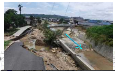
【堤防の決壊】左岸L=200m 右岸L=300m 末政川左右岸0k700付近(県)
