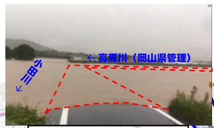
【堤防の決壊】L=100m 小田川左岸3k400付近
