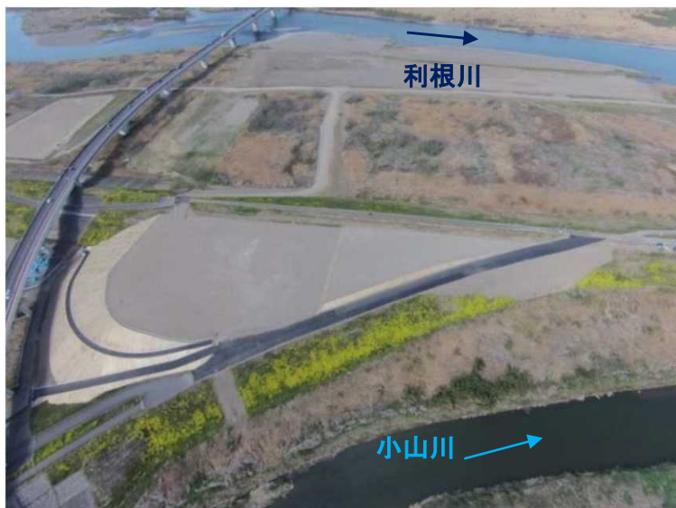
下高島地区(埼玉県深谷市)
