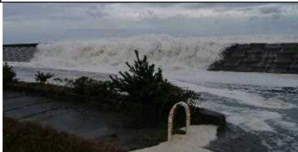
高潮による堤防越波状況
