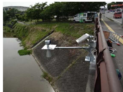
危機管理型水位計の設置
