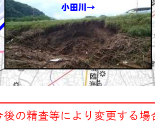
【裏法崩れ】L=15m 小田川右岸4k200付近
