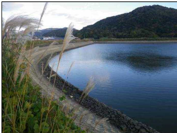
既存ストック(ため池)を活用した調整池の例
