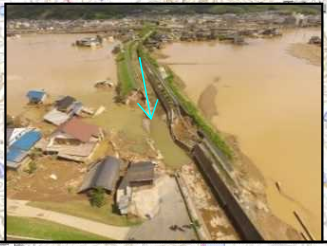
【堤防の決壊】(県) 左岸L=20m(高馬川左岸0k付近) 右岸L=100m(高馬川右岸0k100付近)
