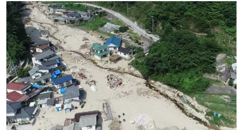
土砂・洪水氾濫(今次洪水)
