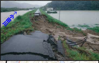
【裏法崩れ】L=30m 小田川右岸0k600付近
