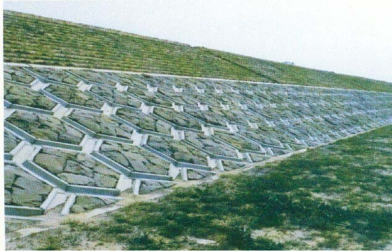
裏石張工（中詰石を使用している亀甲張）
