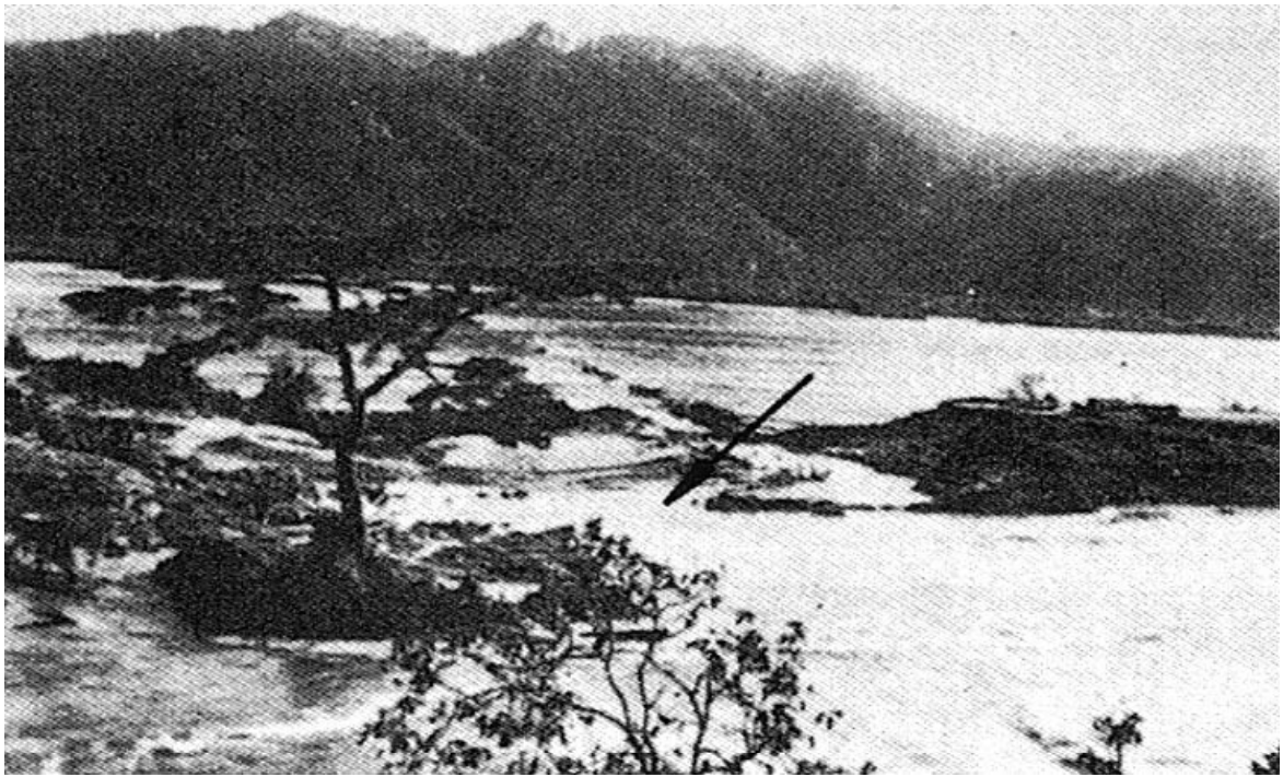
昭和20年9月出水 斐伊川町出西下阿宮地区堤防決壊
