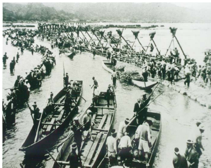
出雲結による水止め作業 (昭和9年9月 出西村阿宮堤 しゅっさいむらあぐ )
