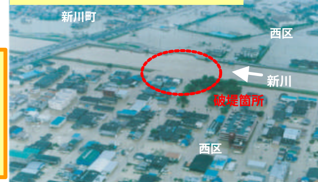
新川の破堤氾濫による浸水状況
