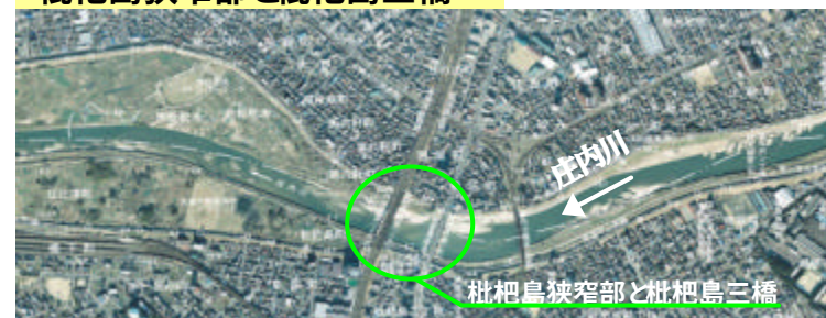
枇杷島狭窄部と枇杷島三橋
