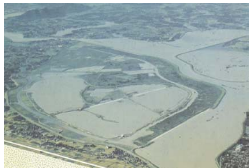
渡良瀬遊水地 (昭和57年9月洪水調節状況)
