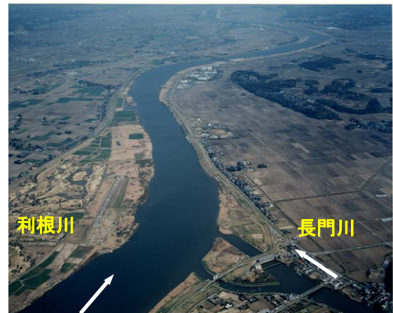
写真 8-8 長門川合流 (約 66km)
