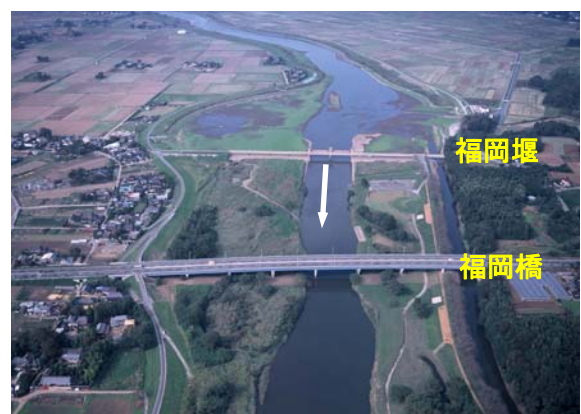
写真 8-24 福岡堰周辺（約 27km）
