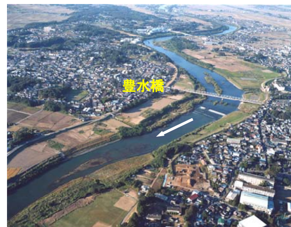
写真 8-22 鬼怒川水海道付近（約 11km）
