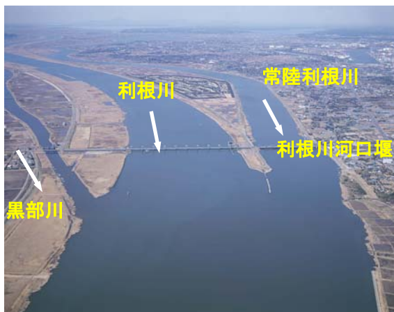
写真 8-9 利根川河口堰 (約 19km)
