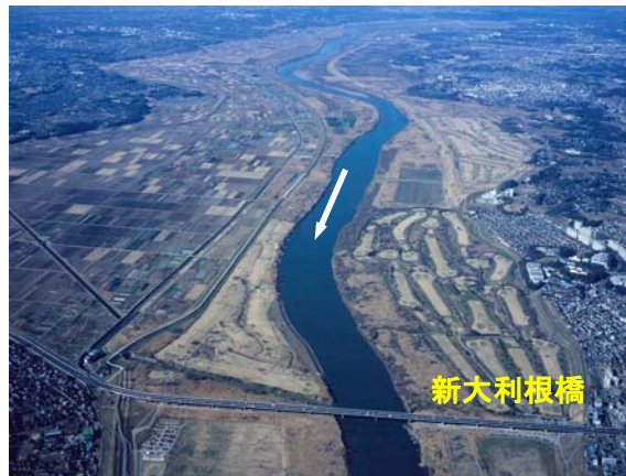
写真 8-6 田中稲戸井調節池周辺 (約 90km)
