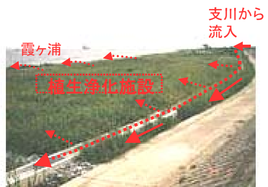
写真 6-3 流入河川の霞ヶ浦合流点にヨシの浄化機能を活用した植生浄化施設を整備
