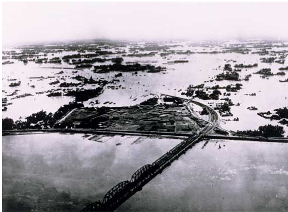
写真 4-11 埼玉県栗橋町（利根川）
