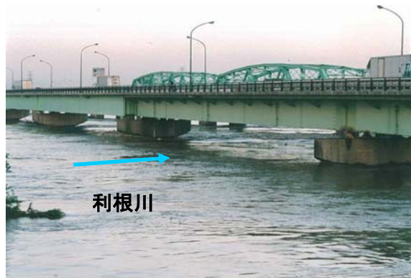
写真 4-31 埼玉県栗橋町（利根川）
