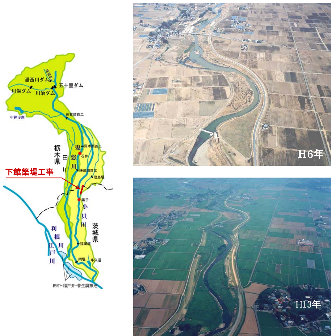
写真 4-34 下館築堤工事（58.8～69.8km 区間）
