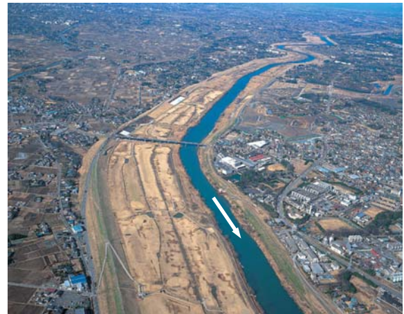
写真 8-32 野田橋 (約 39km) 下流
