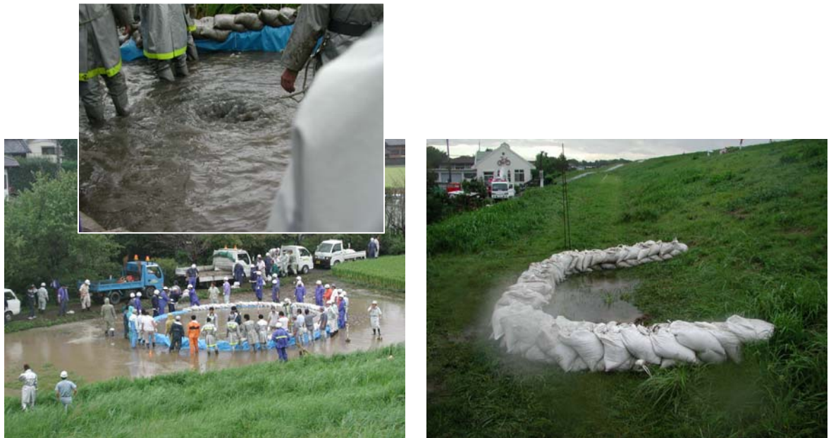
(基盤漏水：釜段工法実施状況)
