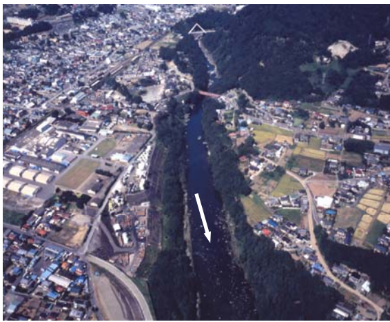
写真 8-15 高津戸地点(約 56km)
