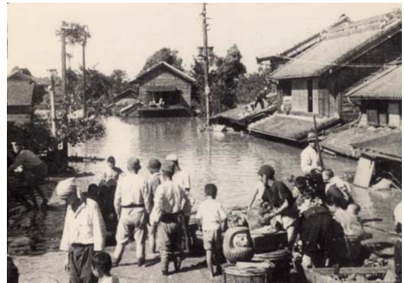
写真 4-12 埼玉県栗橋町（利根川）
