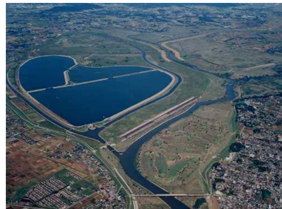
図 4-17 渡良瀬遊水地調節池化工事
