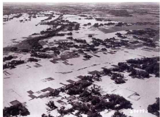
写真 4-14 埼玉県東部（利根川）
