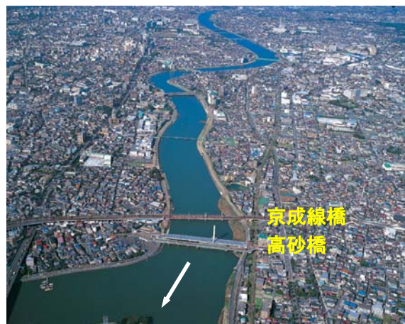
写真 8-36 中川京成線橋（約 12km）付近
