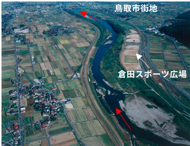
写真 8.1.3 下流域(12.0km 付近)
