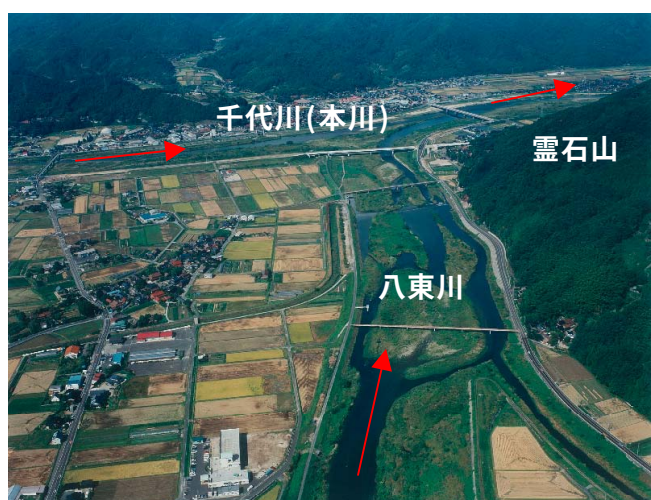
写真 8.1.7 八東川 (1.0km 付近)
