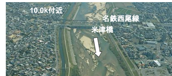
両岸の堤防沿いの市街化の状況
