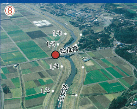
始良橋地点 [KP1.4付近]
