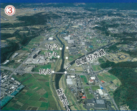
鹿屋分水路合流点 [KP15.8付近]
