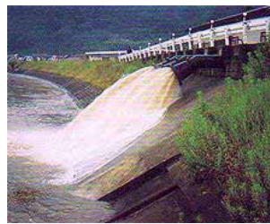
畠敷排水機場運転状況 (H10.10 出水時)
