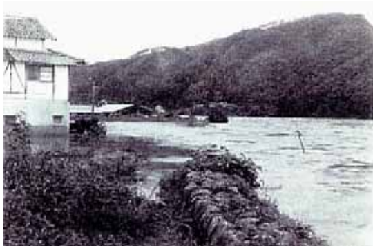
馬洗川左岸 2.2km 付近越水状況
