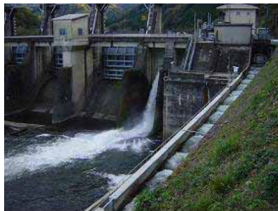
浜原ダムの魚道
