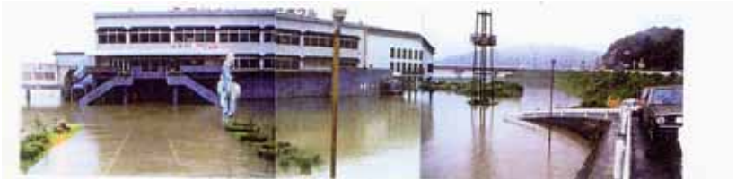
三次市寿橋付近の浸水状況
