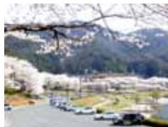
土師ダム親水施設
