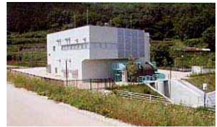
願万地排水機場
