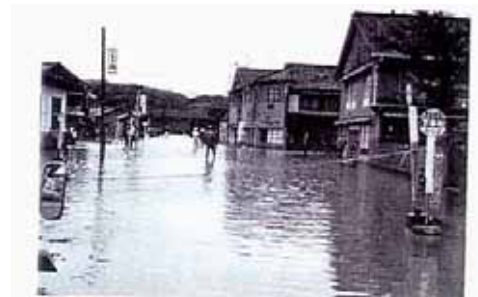
三次市西町の内水による浸水状況
