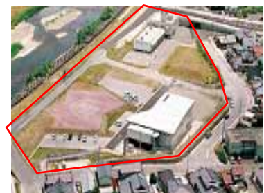
河川防災ステーション
