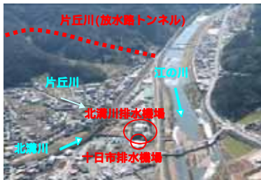
北溝川排水機場
