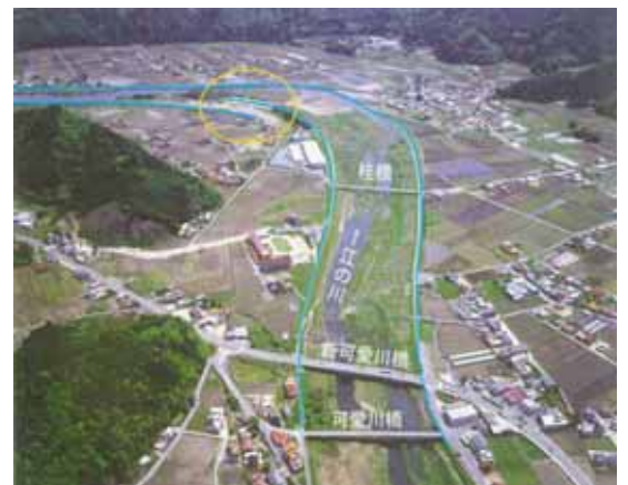
霞堤を利用した治水(安芸高田市吉田町 (175K～176K 付近))
