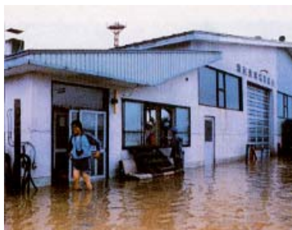
写真 4-1 昭和 56 年台風 12 号による被災状況
