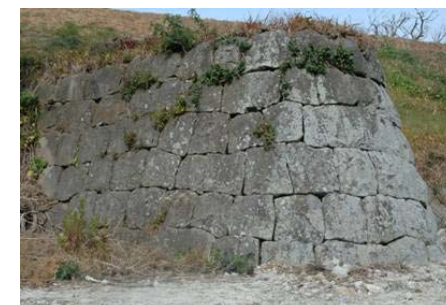
【石はね】 加藤清正によって設置され、菊池川の下流部に現存し、下流部の集落を堤防の決壊等から守ってきた。歴史的遺構として菊池川の名所となっている
