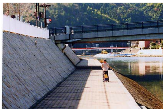
大和橋右岸アンダーパス(散策道)
