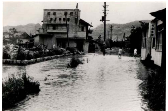
大竹町内(当時)の浸水状況
