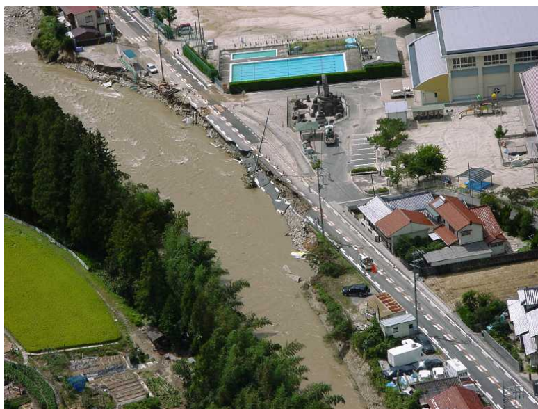
玖島川の被災状況(広島県廿日市市)
