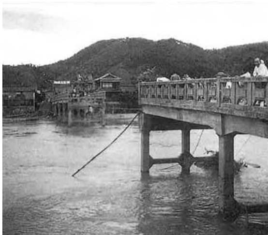
大和橋落橋の跡
