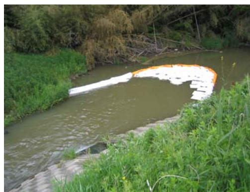
写真 9-3 油流出の際の対応（オイルフェンス）
