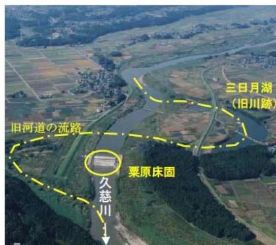
写真4-7 栗原・門部捷水路付近 (2002 年 12 月撮影)
