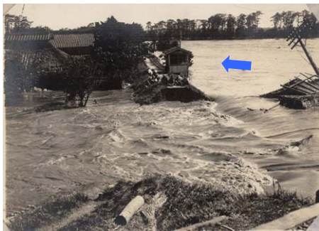
久慈川本川堤防決壊（左岸） （日立市留）
