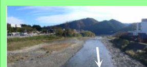
湯の里大橋下流 (流量中)
