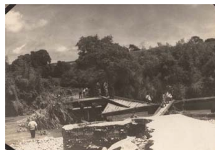
洪水によって破壊された支川里川の茅根橋 (茨城県常陸太田市)
