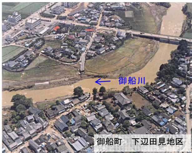
写真 4-3 昭和 63 年 5 月洪水時の状況 (出典：熊本河川国道事務所)
