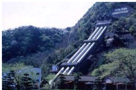
姫川第七発電所
