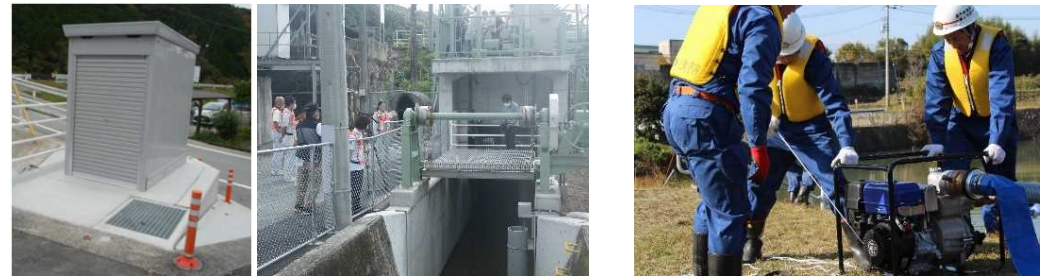
内水排水ポンプ
