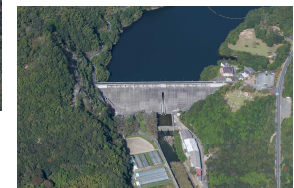
八塔寺川ダム
