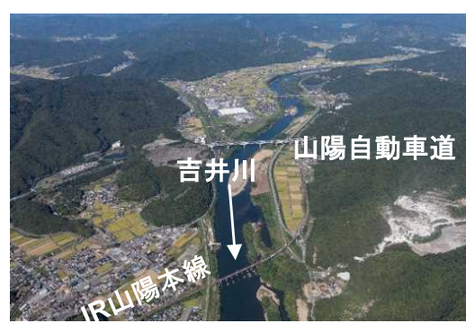
③下流部: 鴨越堰~新田原井堰 (約7~32km)
