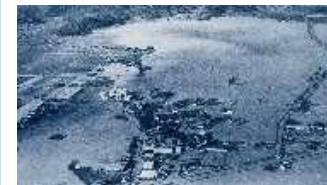
瀬戸内市長船町の浸水状況
