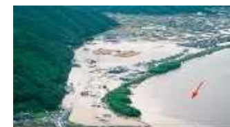
国道374号の冠水(赤磐市)
