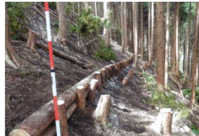
丸太筋工の完了状況
