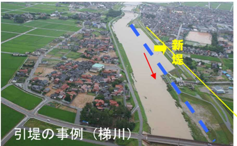
引堤の事例(梯川)
