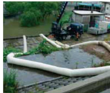
赤磐市福富地区 排水ポンプ車の稼働
