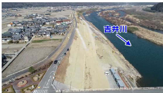
河川改修後（熊山地先 撮影日：令和4年(2022年)3月）
