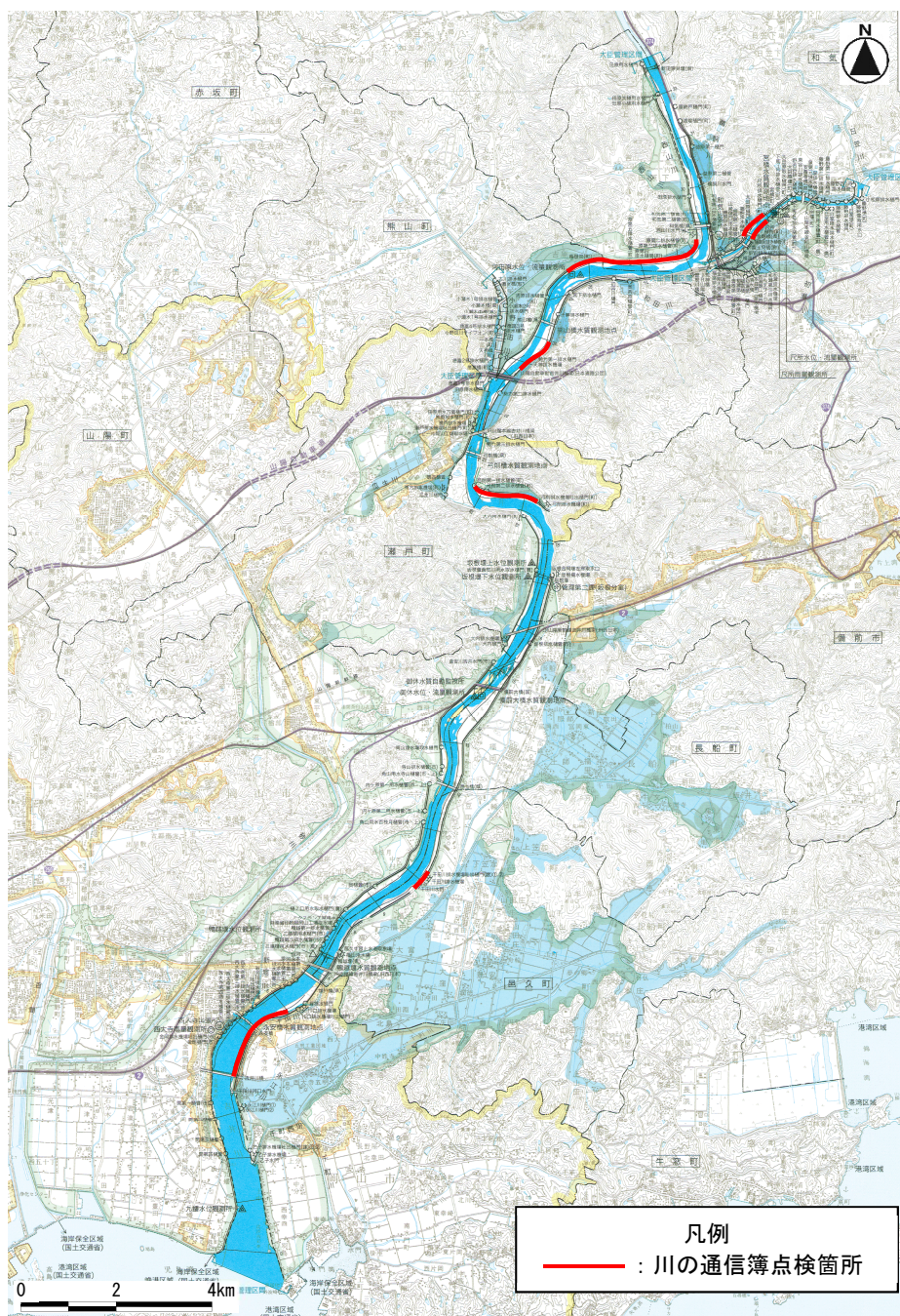
図-10.1.1 川の通信簿点検箇所
