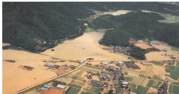
瀬戸内市長船町の浸水状況
