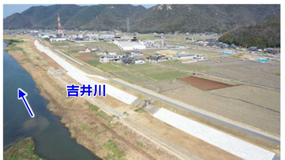
河川改修後（田原地先 撮影日：令和3年(2021年)3月）
