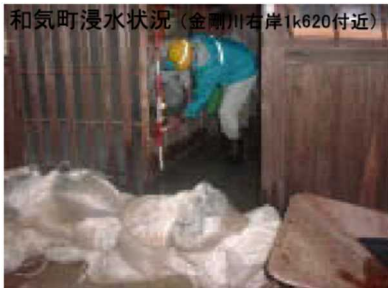
和気町浸水状況(金剛川右岸 1K620 付近)
