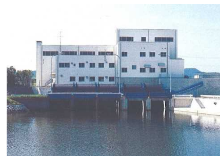
干田川排水機場
