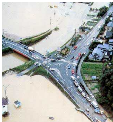
赤磐市吉井町福田 (岡山県土木部河川課ウェブサイト)
