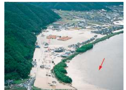
赤磐市吉井町福田 (岡山県土木部河川課ウェブサイト)
