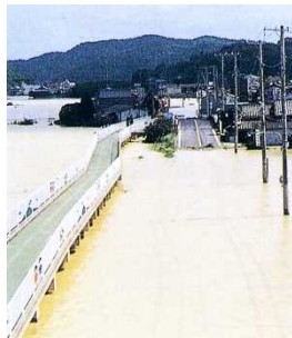
瀬戸内市邑久町の浸水状況
