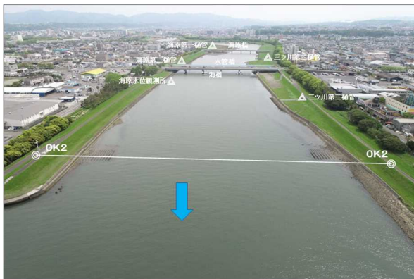
乙津川河口部 (0k2 付近)
