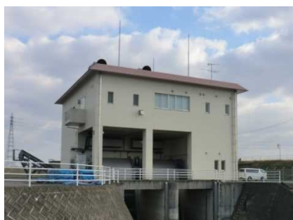
写真 9-1 北鼻川排水ポンプ場
