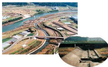
写真 4-9 乙津川分流堰（溢流堰）
