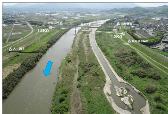
大野川からの乙津川導水路 (12k0 付近)
