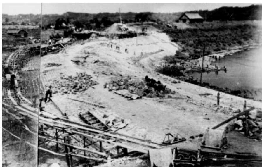
写真 4-2 昭和 18 年当時の築堤状況（大野川 8k400 左岸付近）
