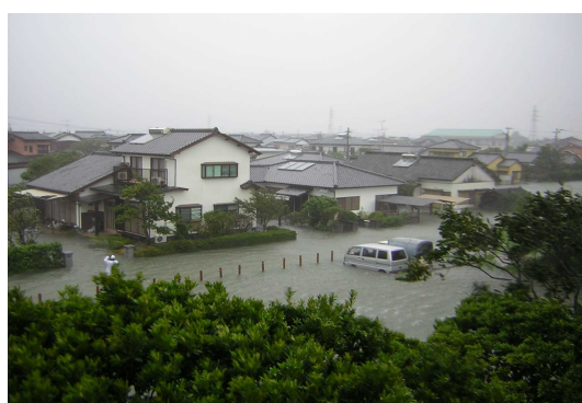
内水被害状況（高鍋町）
