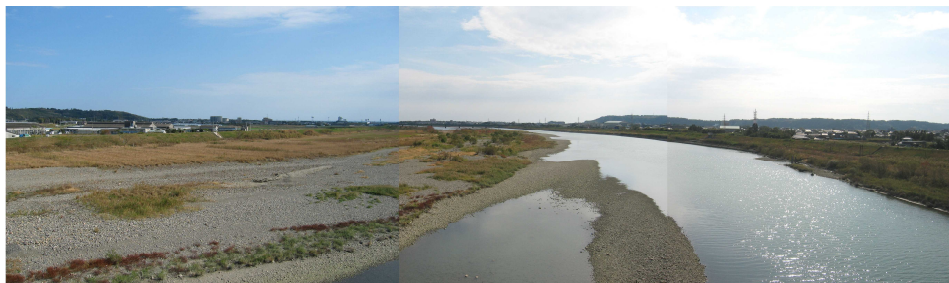
写真 8-4 高鍋大橋より小丸川下流を望む
