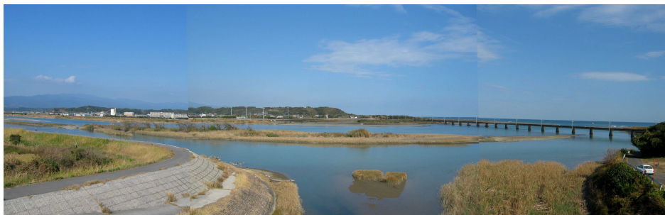
写真 8-5 宮田川より小丸川河口を望む
