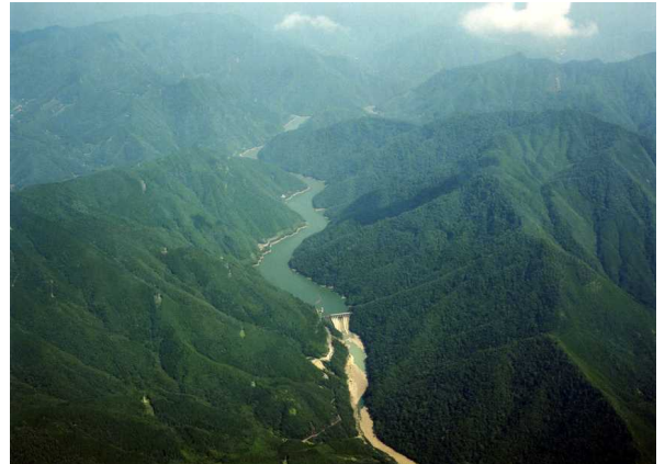
【小丸川上流部（松尾ダム付近）】
