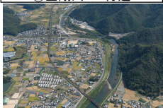
③⑧金剛川 大臣管理区間上流端k付近
