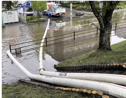
排水ポンプ車による排水状況
