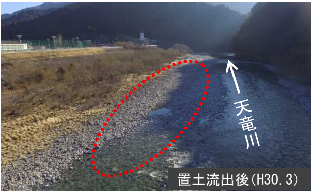
置土流出状況 (65. 0k付近、約1万m 3 )
