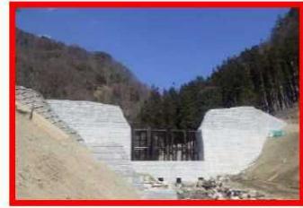
砂防堰堤等の整備
