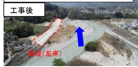
令和元年度 天竜川下久堅築堤護岸工事
