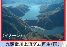
九頭竜川上流ダム再生（国）
