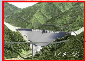
足羽川ダム建設（国）
