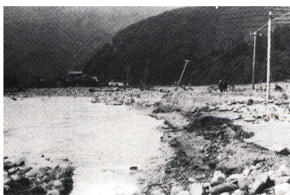
大野郡和泉村（現大野市）朝日付近の被災状況
