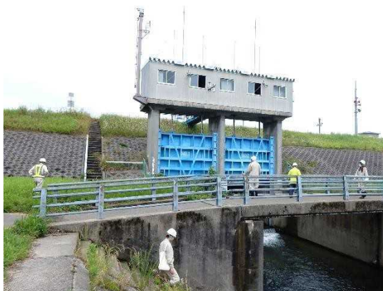
図 9-25 樋門点検状況
