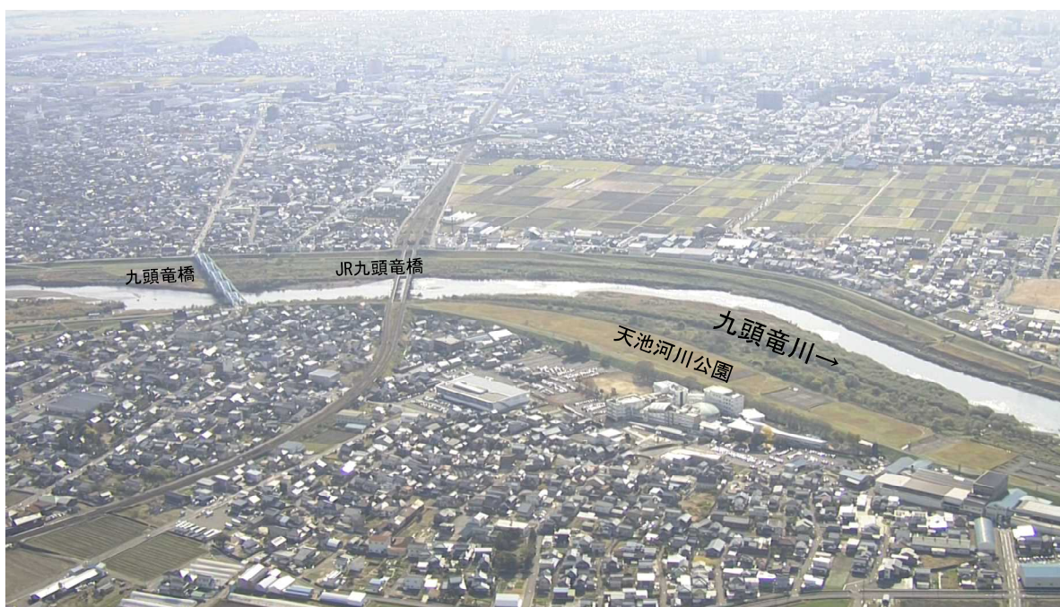
図 8-9 JR九頭竜橋付近(令和3年11月撮影)
