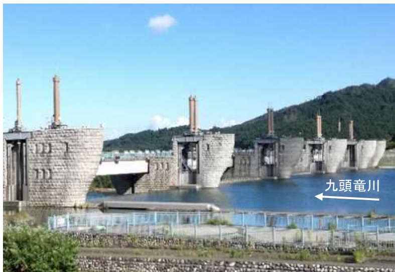
図 4-23 九頭竜川鳴鹿大堰
