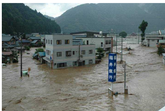
美山町役場付近の浸水状況（福井市（旧美山町）朝谷島）
