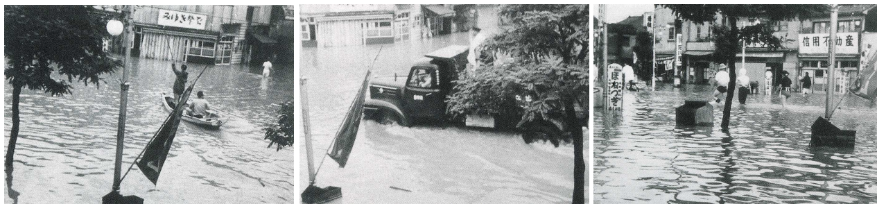
福井市城の橋通りの浸水状況（福井市提供）
