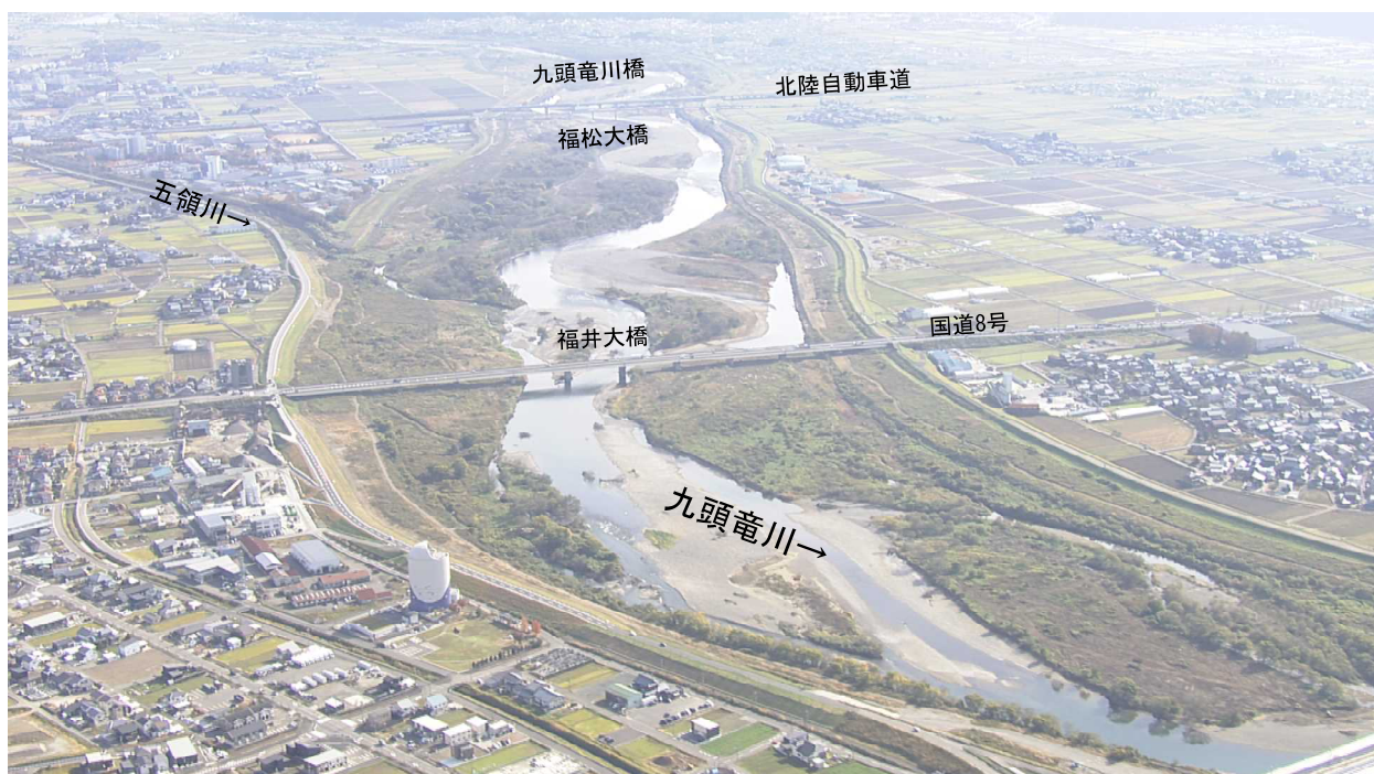
図 2-3 九頭竜川中流 24km 付近（令和 3 年 11 月撮影）
