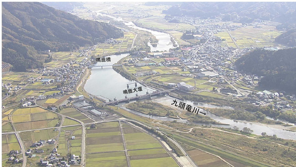
図 8-7 鳴鹿大堰付近(令和3年11月撮影)
