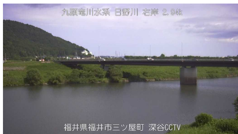
図 9-21 CCTV 提供画像
