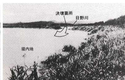
福井市三郎丸付近 日野川の破堤箇所を望
