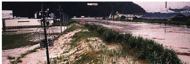
堤防からあふれ出す（浅水川右岸 JR 北陸本線下流付近）
