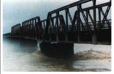
福井市高屋付近高屋橋(県道福井三国線)の橋脚が洗掘のため傾いた
